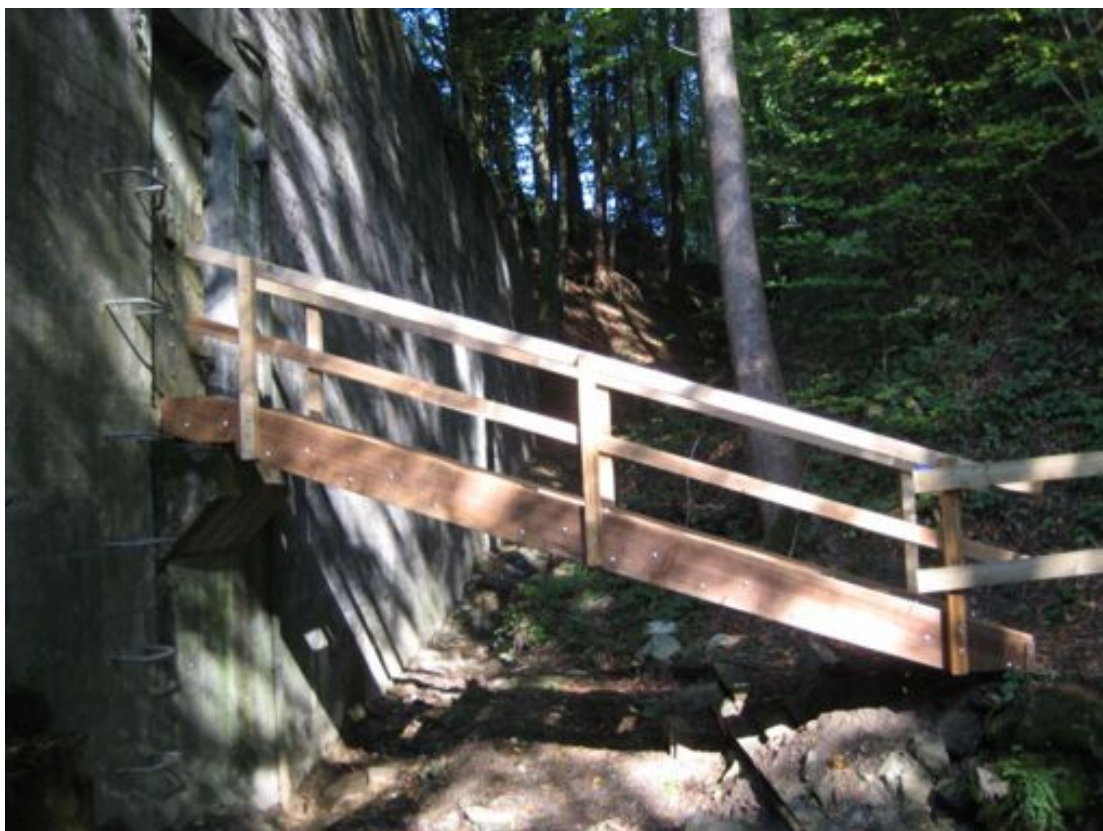
Die neue Zugangsbrücke ins Werk Philippsburg
