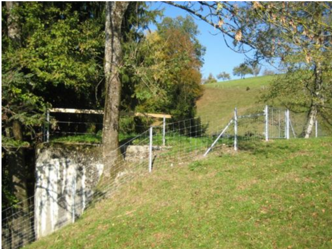
Neue Zäune und Schranken erhöhen die Sicherheit auf dem Werk Philippsburg
