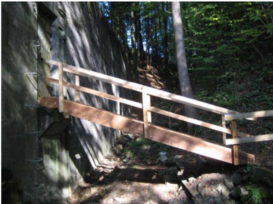
Die neue Zugangsbrücke ins Werk Philippsburg
